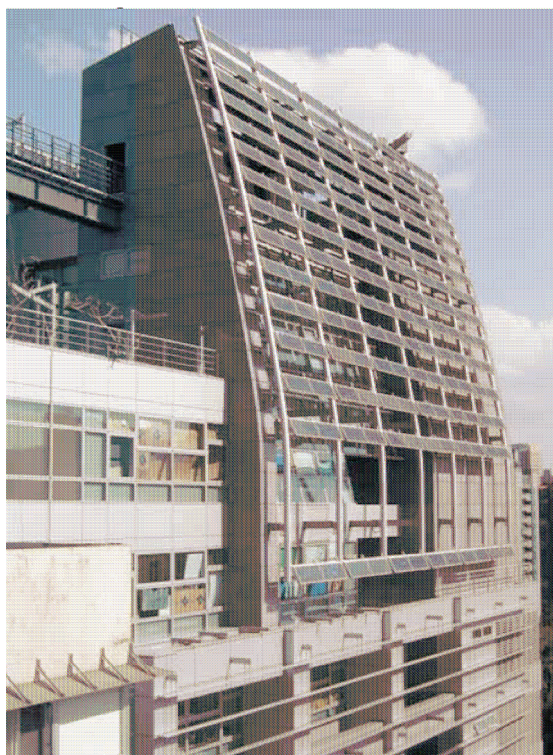
Figura 12 – Módulos fotovoltaicos instalados em brises
