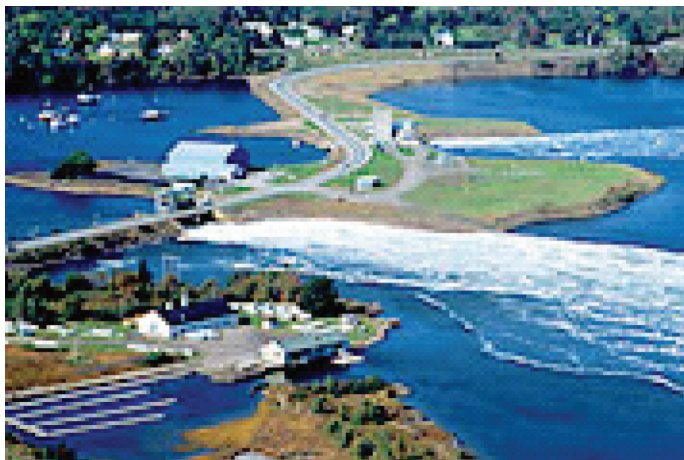
Figura 6 - Usina maremotriz de Annapolis, Canadá
