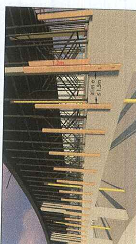
4ª ETAPA: OS VIGOTES DEVEM ESTAR TOTALMENTE FIXOS E SEM FOLGA DE MANEIRA QUE OFEREA RESISTÊNCIA E FIRMEZA AO SISTEMA. A ALTURA DOS MONTANTES DEVERÁ SER DE 1,2m CONTANDO A PARTIR DO PISO
